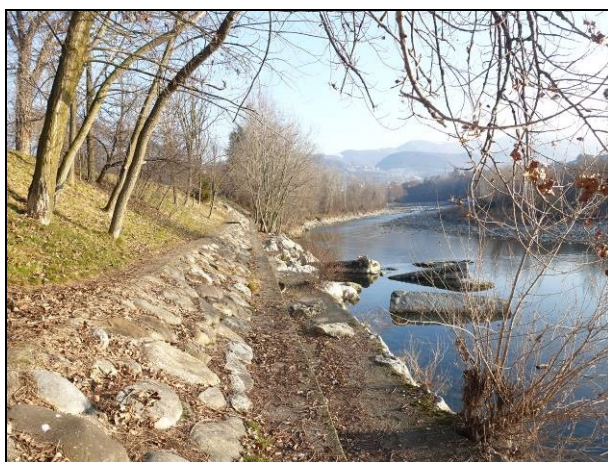
Foto 22 e 23 – Viste su un tubo di scarico e sull'argine in pietrame nella parte bassa della sponda del F. Brembo.
