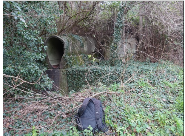
Foto n.19- 22 - Imbocco del tratto tombinato di Valle Doga e rilievo del tracciato della fognatura comunale fra Cà della Zogna e il collettore presso il Fiume Brembo (in Foto 4 è riportato lo scarico dello sfioratore).
